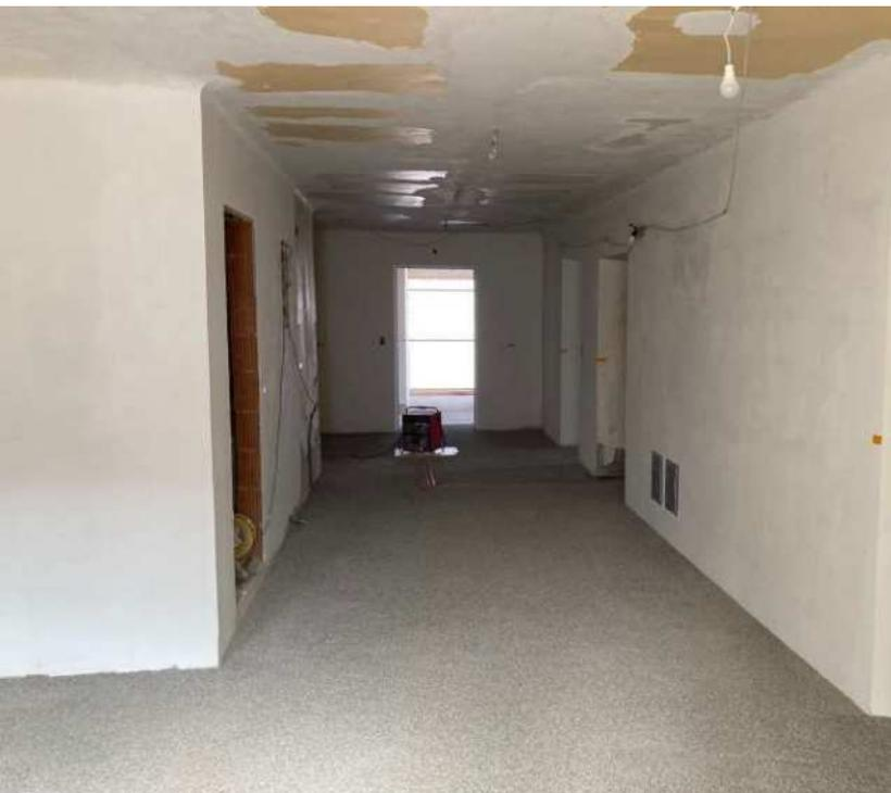
Die Labe am 22.02.2025: Die Türscheiden und Wände verputzt und gespachtelt und hergerichtet für die Aufbringung der Fußbodendämmung
