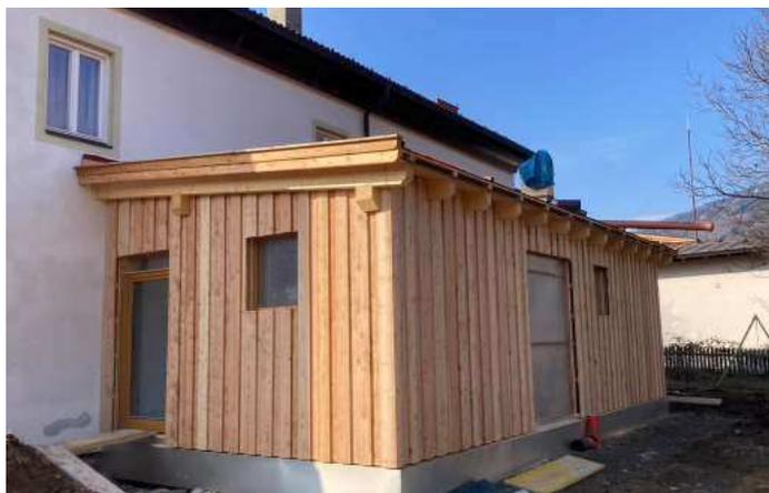
24.2.2025: Mit Lärchenholz verkleideter Zubau für die barrierefreien Sanitärräume und dem Eingang ins 1.OG
