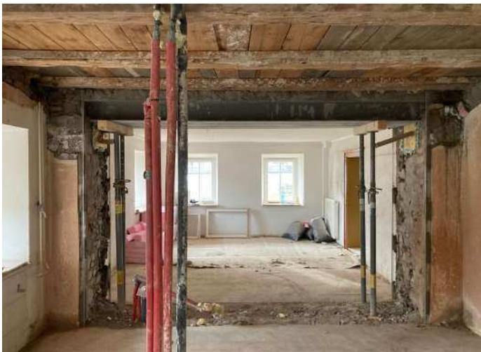
Blick in den Saal nach dem Abriss der Mauern und Einzug der Stahlträger
