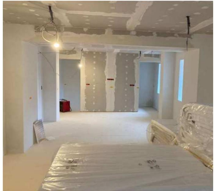
26.02.2025: Innenausbau im neuen Saal - Rigipsdecke und TV-Wand, Fußboden bereits gedämmt
