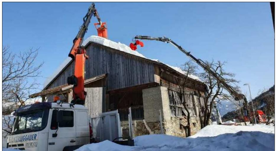
*Der Lenker des großen Kranes steuerte sein Gefährt vom Arbeitskorb des 2. Kranwagens. So sah er direkt vor Ort exakt wohin er mit seiner hydraulischen Schaufel greift, um möglichst wenig zusätzlichen Druck auf das Dach zu bringen.*
