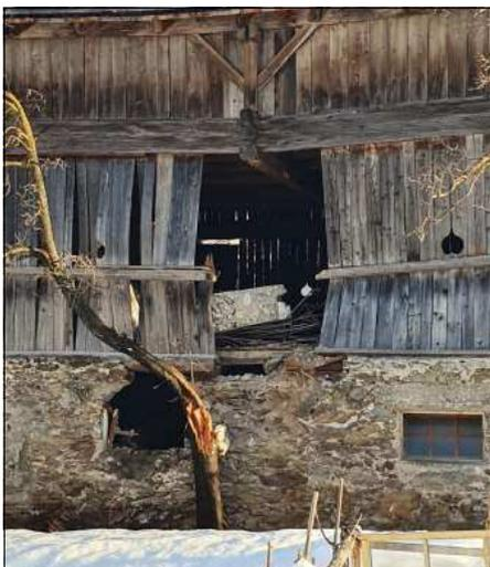
*Ein betonierter Pfeiler in der Breite von etwa 1 m brach am Mauerfuss aus und knickte nach innen.*
